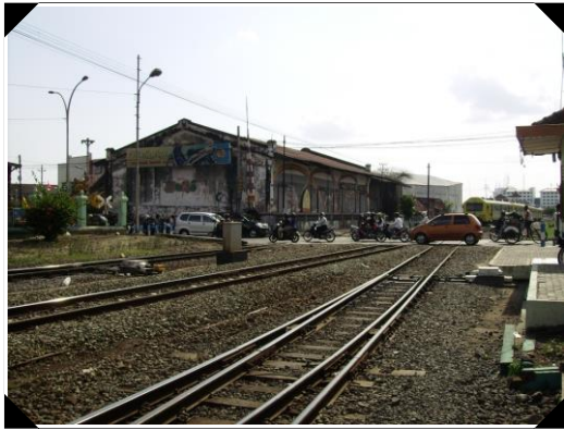
Sepur sebidang dengan jalan raya
