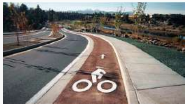
Bike lane dengan flexible pavement
